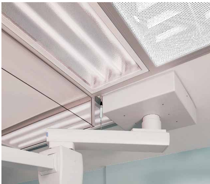
Zdjęcie stropu laminarnego wraz z: kurtyną powietrzną wykonaną ze szkła wzmocnianego lub pleksiglasu, oświetleniem bocznym (klasa obudowy IP 65), wlotem modułu cyrkulacyjnego wykonanym z płyty perforowanej ze stali nierdzewnej.
