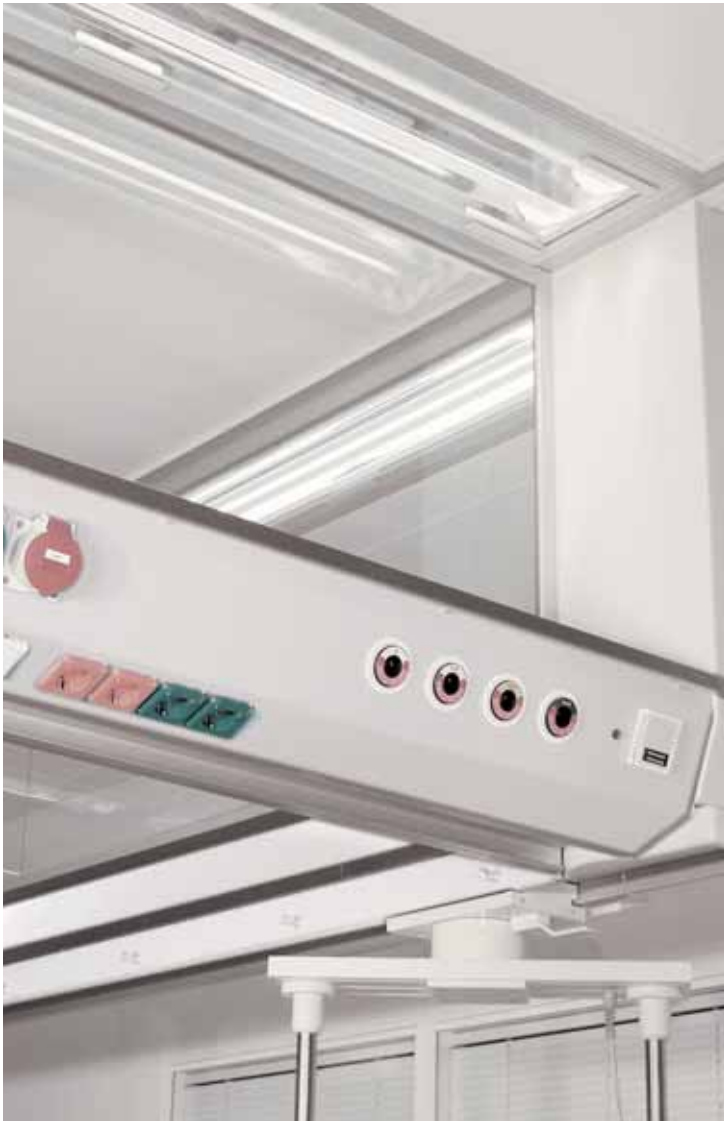
Most anestezyjologiczny: system modułowy dostarczający gazy medyczne, próżnię, AGSS, zasilanie i dane, zapewniający łatwy dostęp (budowany na zamówienie indywidualnie dla każdego projektu, zgodnie z wymaganiami klienta)
