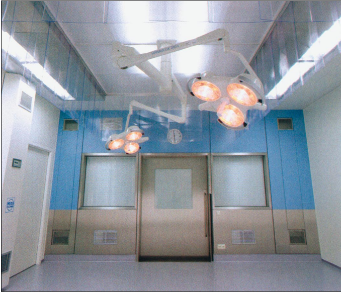
Rys. 11. Rozmieszczenie kratki wywiewnych w sali operacyjnej
