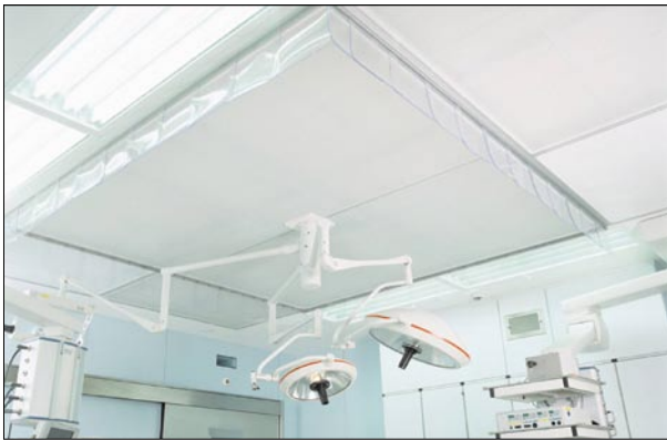
Rys. 9. Laminarny strop z bezpośrednią recyrkulacją z pomieszczenia [8]
